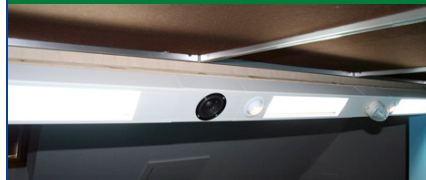
Hier wurden mehrere Beleuchtungseinheiten auf einem gemeinsamen Grundbrett befestigt und über der Anlage montiert.
